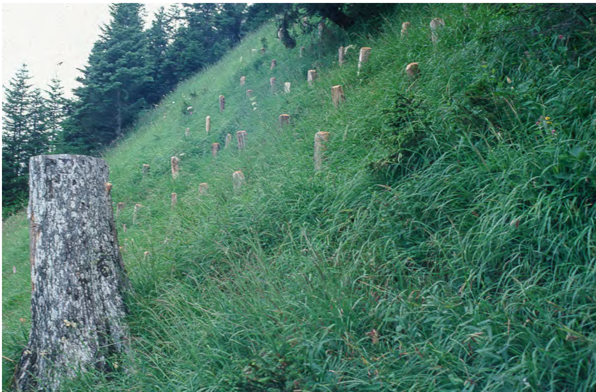
Abb. 16: Datum: 1991-07-24 Bild-Nr.: Dia W1-0457 Pfählung gegen Schneegleiten
